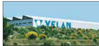
Lisbon, Portugal Velan Válvulas Industriais, Lda.
